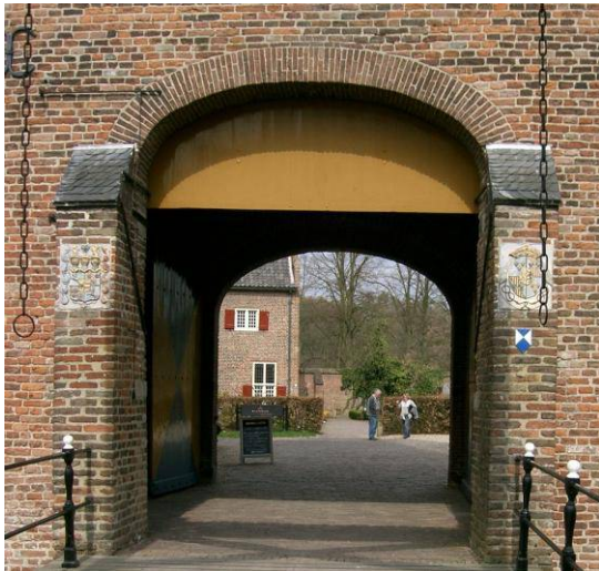
Afb. 3. Steunboog boven de voorburcht van Kasteel Doorwerth.
